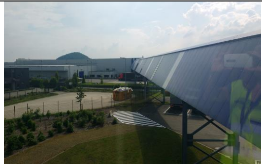
Figuur 12 Zicht op luchtbrug en westelijk gebouw (vanaf oostelijk gebouw)
