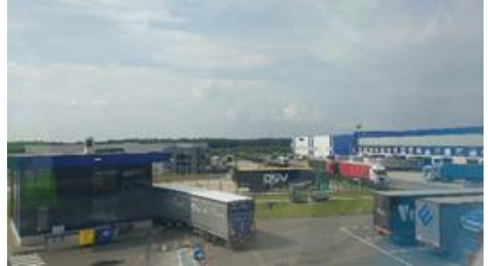
Figuur 14 Zicht op oostelijke opslagloods en op onthaal vrachtwagens
